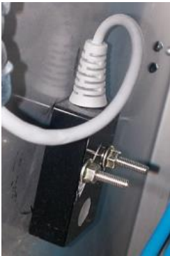
< UV 센서 설치 예시 >
